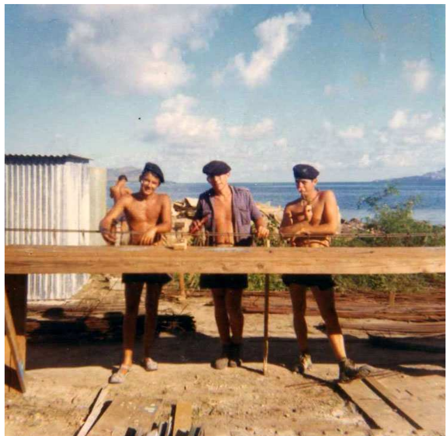
Ferrailage du local technique abritant la pompe pour le système d'arrosage du toit de l'abri. (Olivier Verrier)
