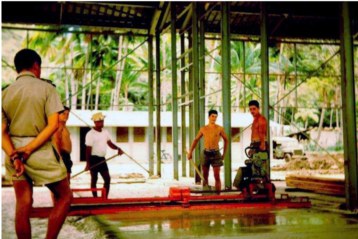
Construction de la dalle de l'abri « Pantz », fin 1967 (Olivier Verrier)
