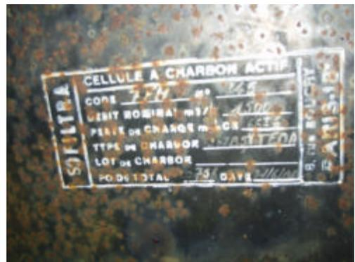
Restes des caissons à charbon actif datés de juin 1968 et destinés à épurer l'air des iodes radioactifs avant insufflation dans le hangar destiné à la protection des populations lors des retombées radioactives à Rikitea sur l'île de Mangareva (Gambier).
