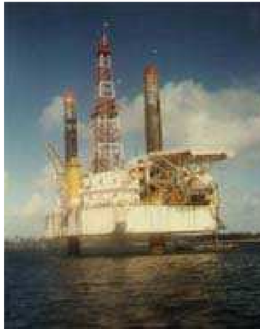
Bouygues Offshore. Plateforme de forage en 1987 (photo JP Moreau)
